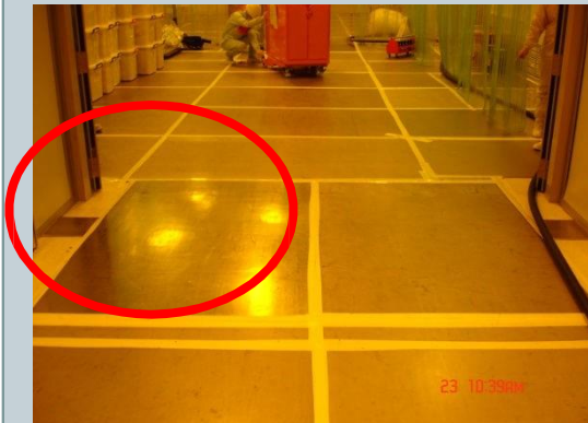
過檻處鐵板鋪設
