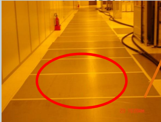
鐵板接合處需使用膠帶固定
